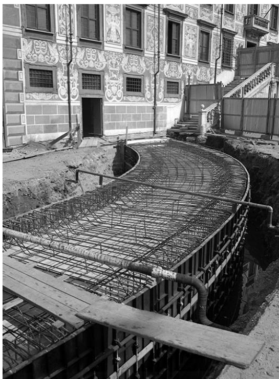
Costruzione del sottopasso che collega il Palazzo della Carovana al Palazzo dell'Orologio
